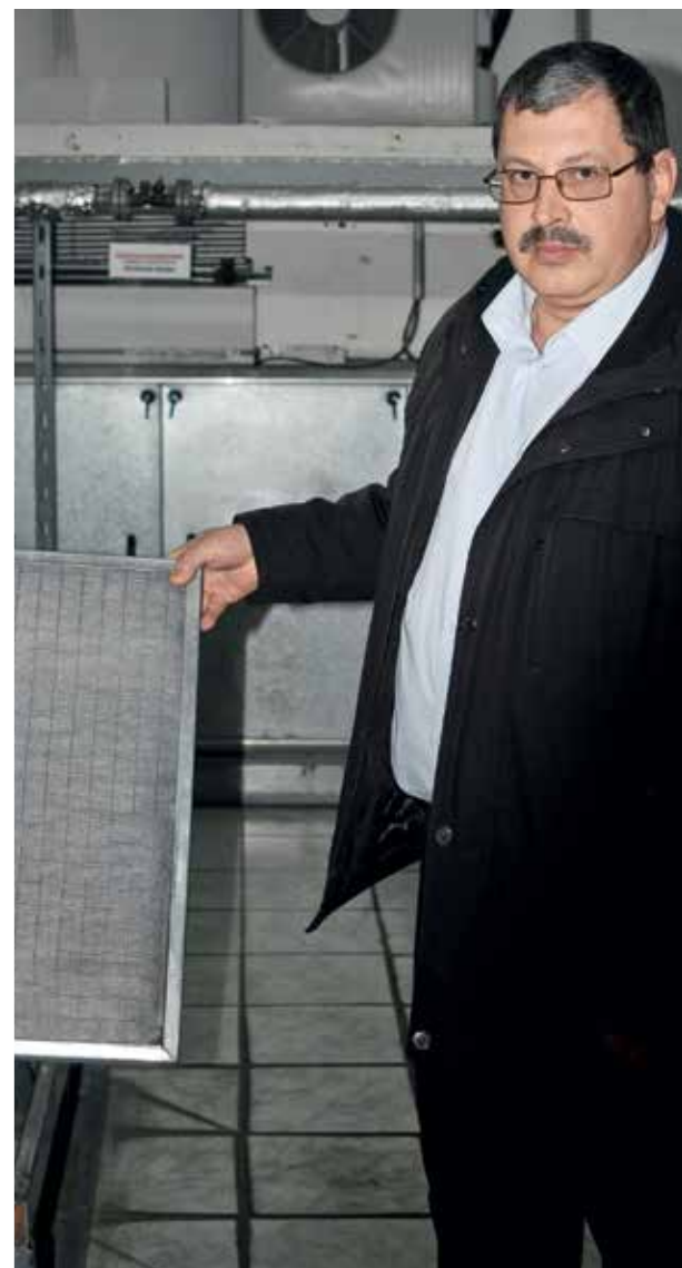
Начальник службы вентиляции Храма Христа Спасителя Сергей Белов демонстрирует кондиционеры под нижней Преображенской церковью. Это огромные установки, внутри — заборные клапаны, мембранные глушители, две секции фильтров и теплообменник. На выходе — две трубы с подготовленным воздухом
