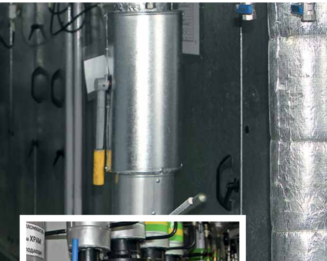
Начальник службы вентиляции Храма Христа Спасителя Сергей Белов демонстрирует кондиционеры под нижней Преображенской церковью. Это огромные установки, внутри — заборные клапаны, мембранные глушители, две секции фильтров и теплообменник. На выходе — две трубы с подготовленным воздухом
