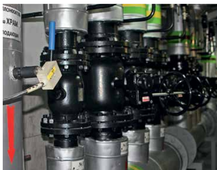
Начальник службы вентиляции Храма Христа Спасителя Сергей Белов демонстрирует кондиционеры под нижней Преображенской церковью. Это огромные установки, внутри — заборные клапаны, мембранные глушители, две секции фильтров и теплообменник. На выходе — две трубы с подготовленным воздухом
