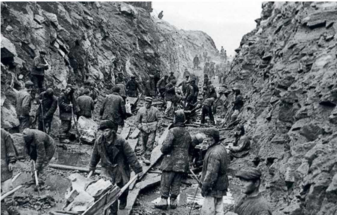
Заключенные на работах по выемке скального грунта при строительстве железнодорожной линии Сорока (ныне город Белозерск) — Обозерская. Конец 1930-х гг. Фото из ГА РФ
